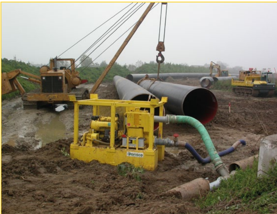
Drainage excavation for pipeline installation Grabenentwässerung für Gasleitungsverlegung Откачка воды из траншей для укладки газопровода
