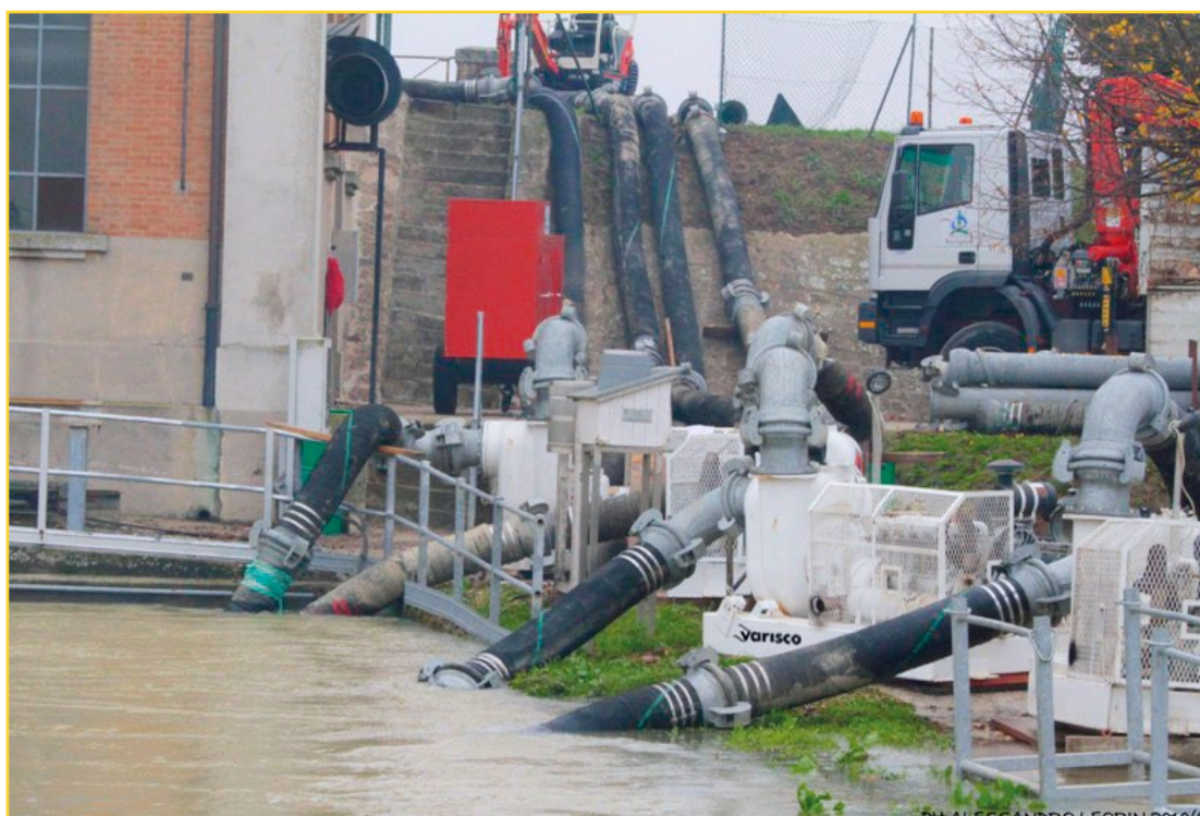
Drainage of flooded area Entwässerung eines überschwemmten Bereichs Осушение затопленной местности
